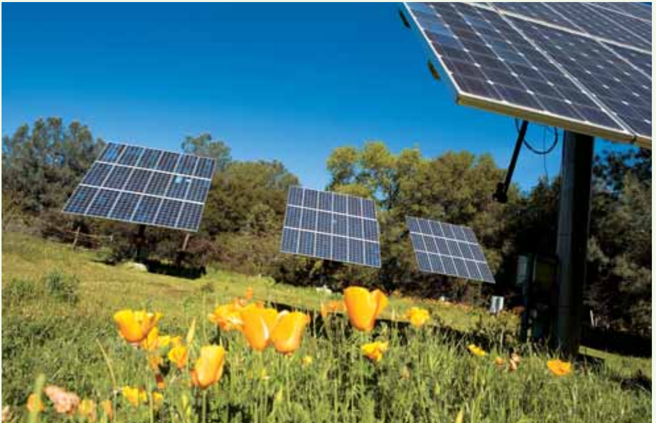
Arriba: Vista microscópica de una nanocélula fotovoltaica; Abajo: Instalación de paneles solares de GE.
