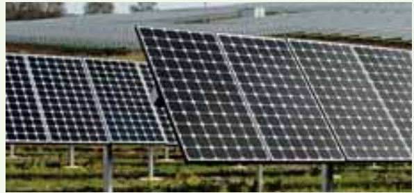
Instalación de paneles solares de GE
